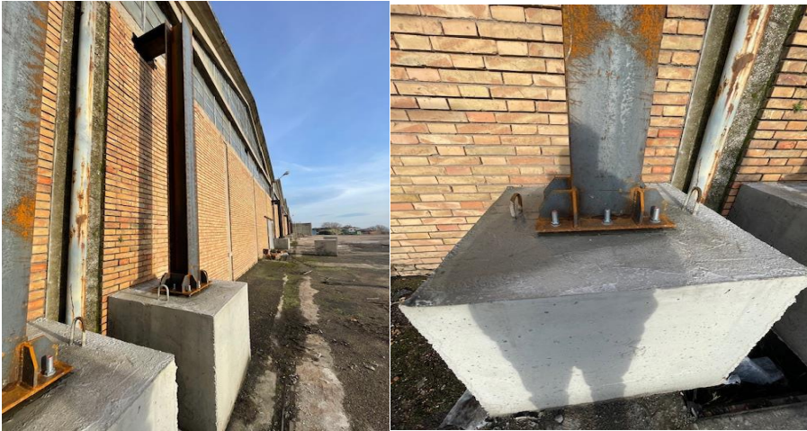
Elementi provvisori in acciaio – puntelli
